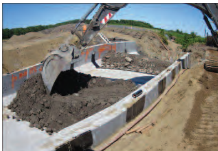
Placement dans un ponceau de bandes composées de matériel à granulométrie étalée et continue (matrice).
