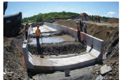
Pas de perte d'eau significative : test d'étanchéité concluant.
