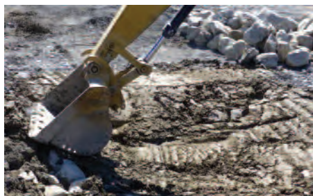
Trou creusé dans le sol, puis tapissé de matériel à granulométrie étalée et continue (matrice).
