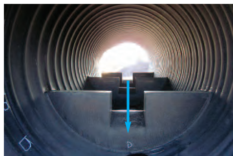
Déversoirs en polyéthylène (vue de l'aval)
